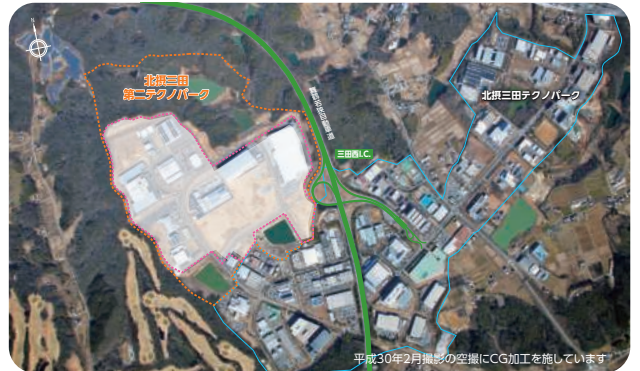
平成30年2月撮影の空撮にCG加工をしています
